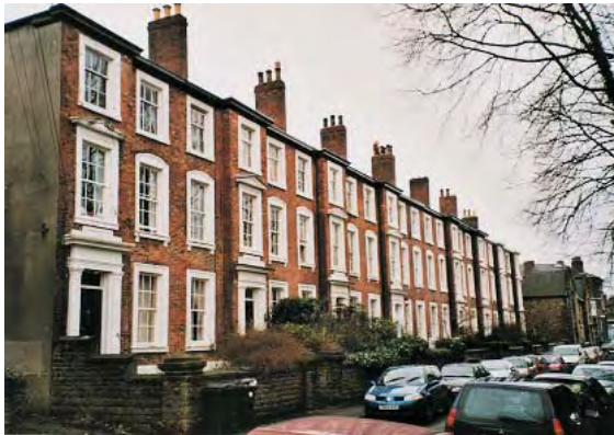
Nos. 6-20 Ashgate Road
